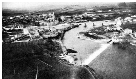
Figure I.3 : Vue aérienne de Labruguière [8].
