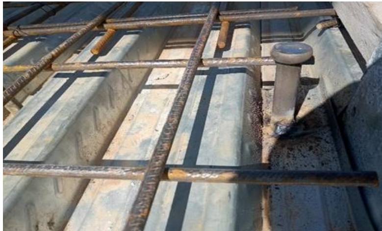
Figure III. 1 : Représentation du plancher collaborant.
