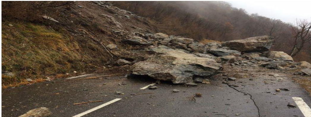
Figure 1.3 : éboulement dans les gorges de la Bourne en Isère
