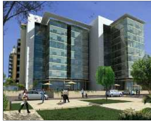
Figure 3.32 la façade de la résidence des pins
