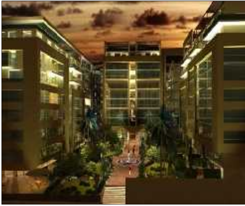
Figure 3.31: la façade de la résidence des pins
