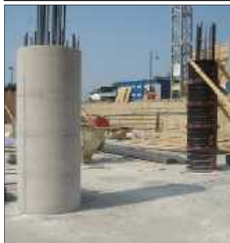
Figure 5.80: poteaux circulaire en béton armé
