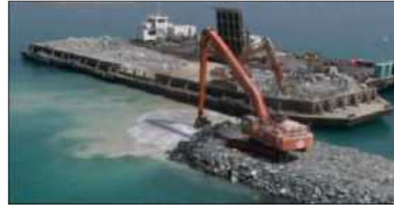
Figure : 5.109. 4eme étape de réalisation de la digue de protection
