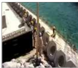
Figure : 5.111. une digue de protection
