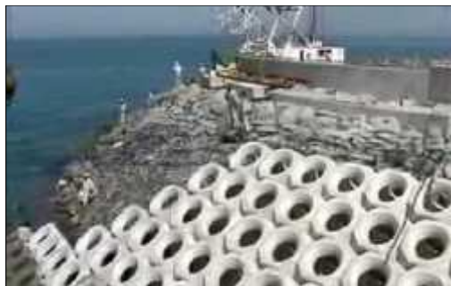
•Vue sur une digue de protection
