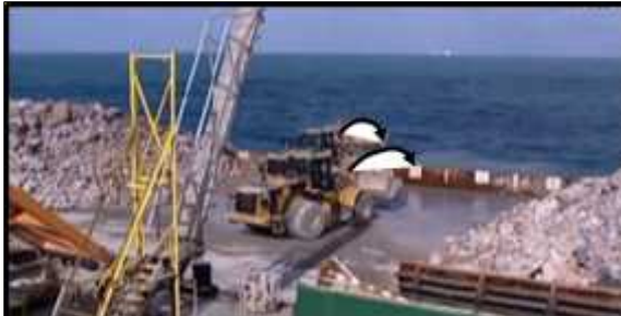
Figure : 5.108. 3eme étape de réalisation de la digue de protection
