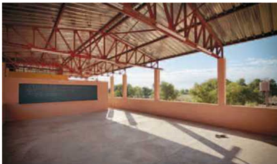
Figure 11: vue générale sur les toitures métalliques Source : raphaëlle saint-pierre, 2013, p16
