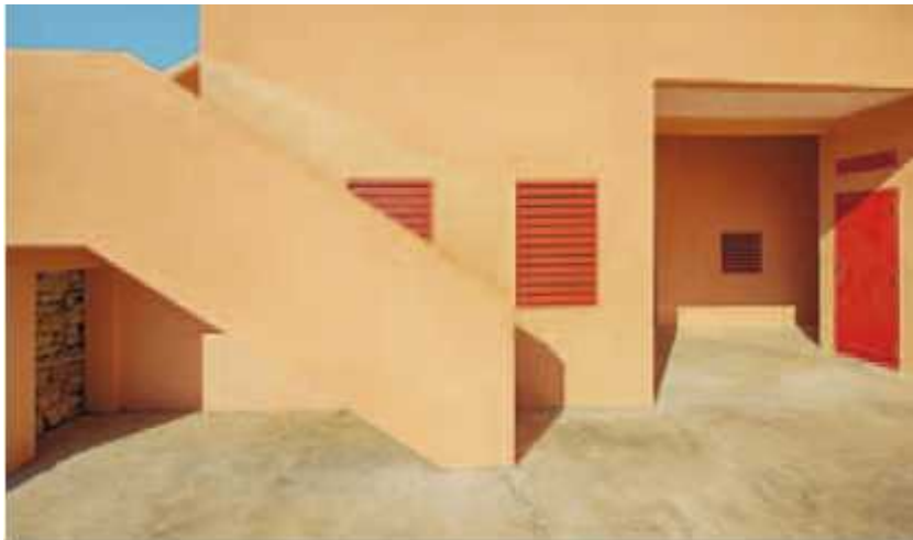
Figure 10 : Les murs de la façade Source : http://www.archidesignclub.com
