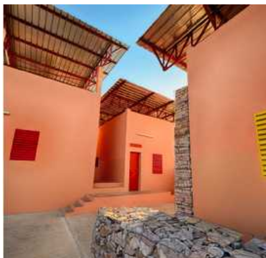
Figure 9: Les façades intérieures Source : http://www.archidesignclub.com
