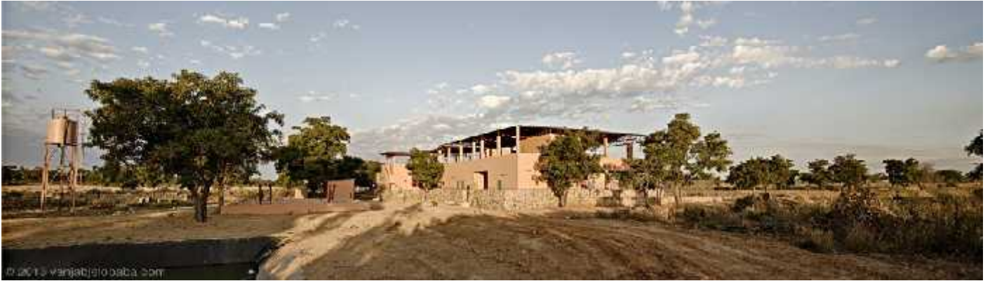
Figure 4: Le centre dans son environnement Source :vanjabjelobaba.com
