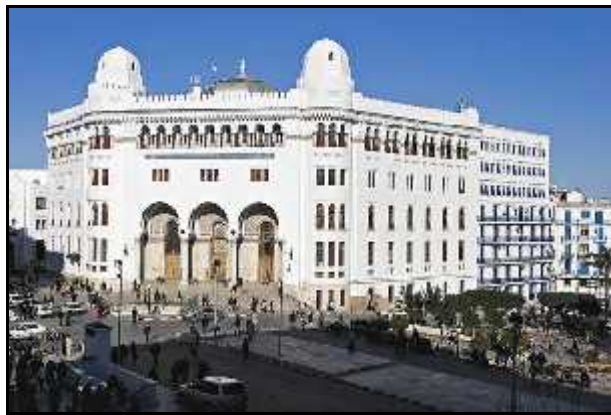
Fig.11_la grande poste d'Alger _ Source www.algerie1.com
