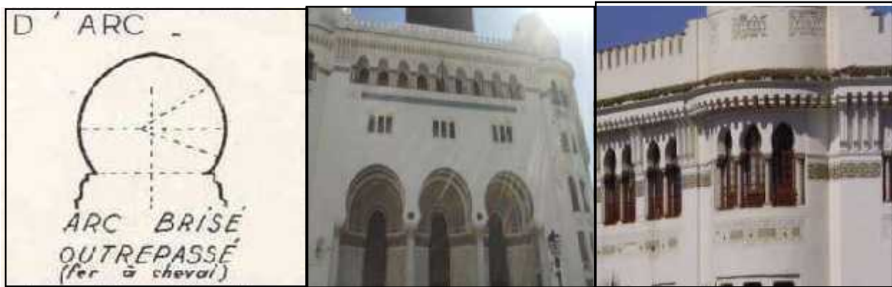
Fig.21 : les différents arcs de la grande poste_Source Google image et les auteurs
