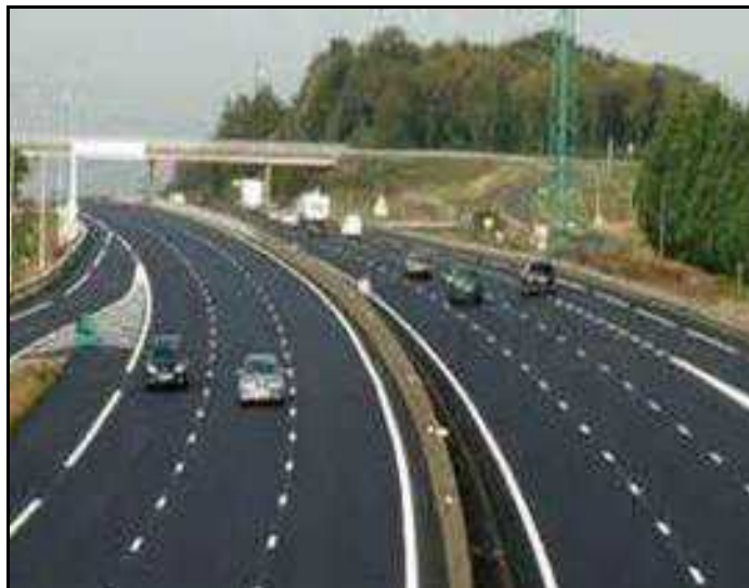
Fig.2 :L'autoroute Est-Ouest d'Algérie_ source Google image
