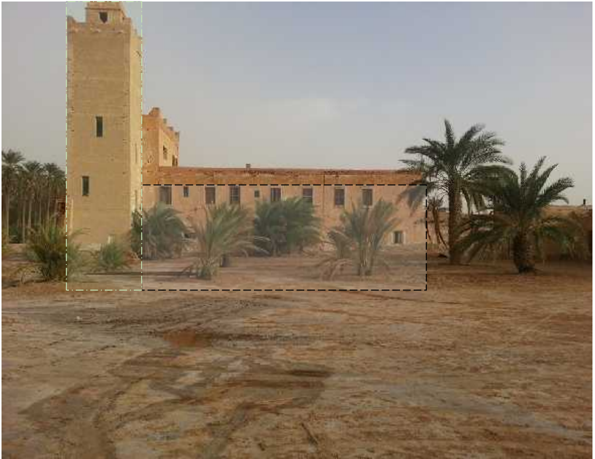
Figure 25 façade ouest -s.auteur
