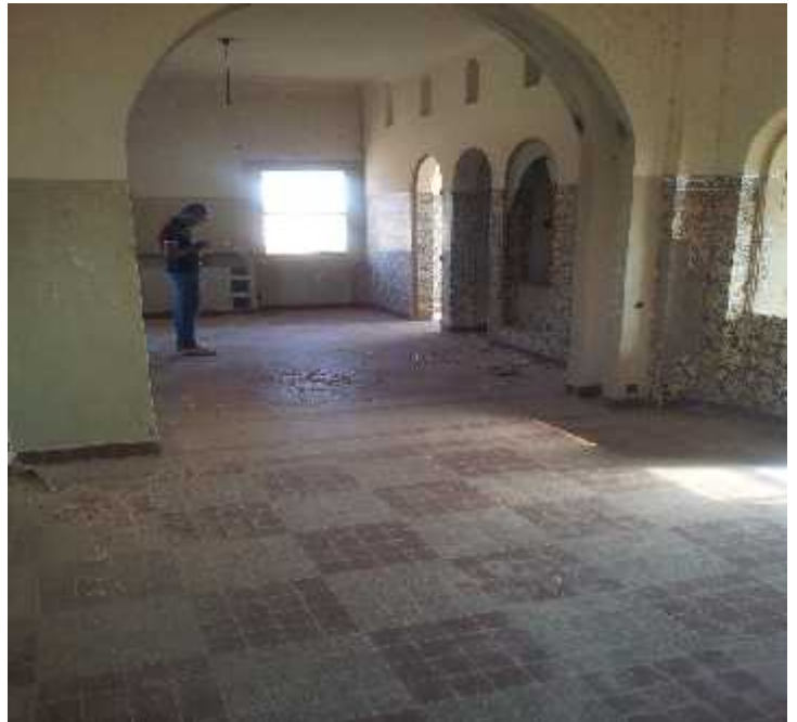
Figure 17 intérieur de la maison -source auteur-
