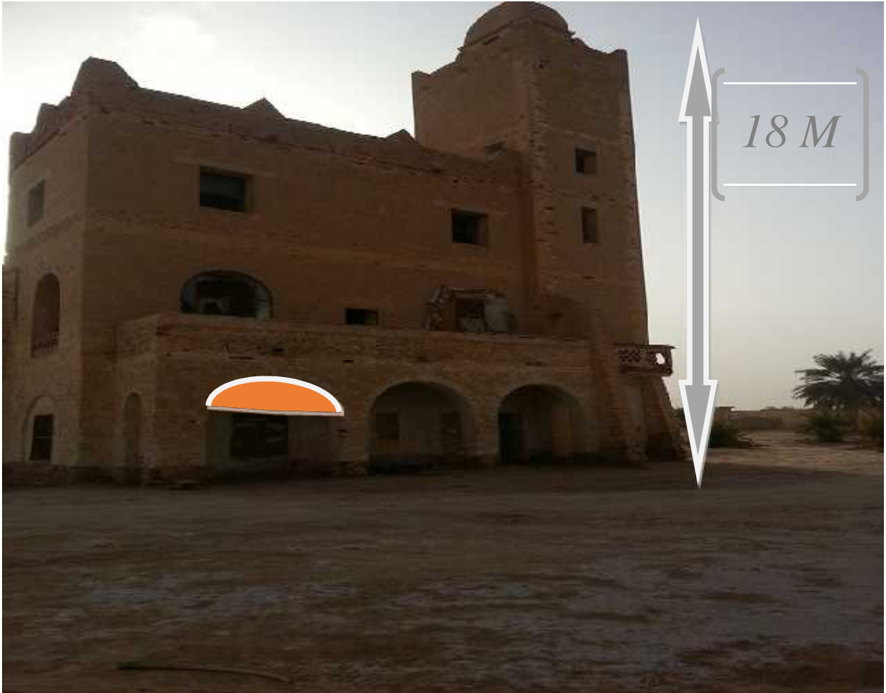
Figure 24 façade nord-source auteur
