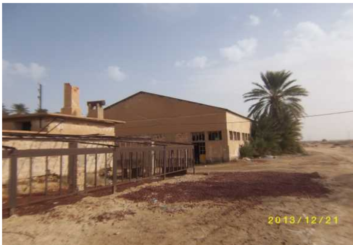
Figure 19 : les Hangars de traitement des dattes -source auteurs
