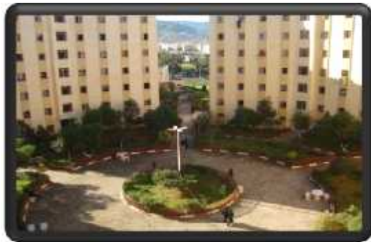
Les bâtiments de la résidence
