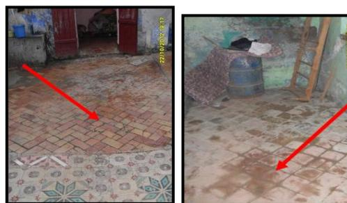
Photo2.6. Déterioration du pavage au niveau du patio et les chambres. Source :SALHI Zahirda.
