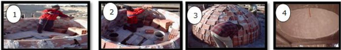
figure1. 9: méthode de construction d'une coupole
