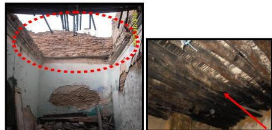
Photo2.3. L'état de dégradation des planchers de la maison
