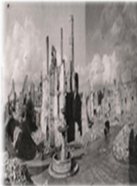
fig 19 :le havre avant reconstruction .
