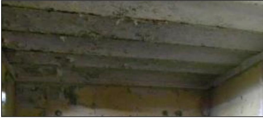
Fig.191, Dégradation de la qualité de l'enduit des planchers, source : Pp
