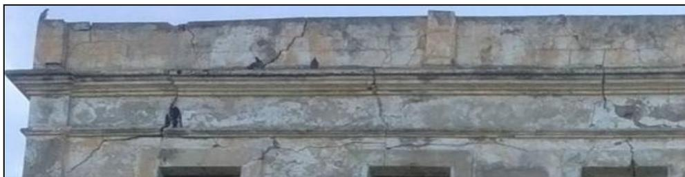
Fig.183, une série de fissures, au-dessus des fenêtres, source : Pp
