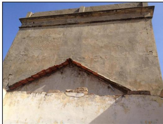
Fig.189, Les traces de la couverture inclinée en tuile, source :Pp
