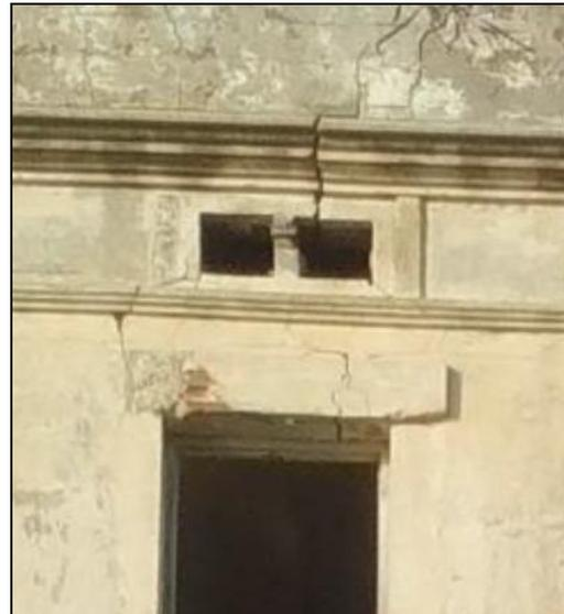
Fig.172, Fissure verticale au-dessus de la petite ouverture, source : Pp
