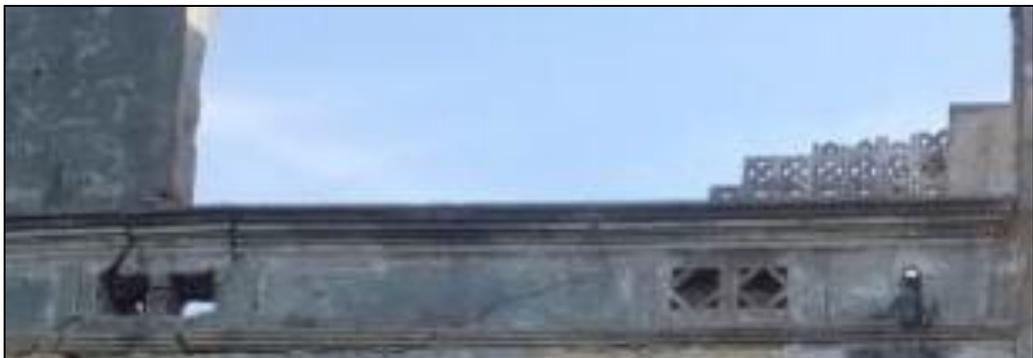
Fig.193, perte de la matière au niveau des carreaux du garde-corps, source :Pp
