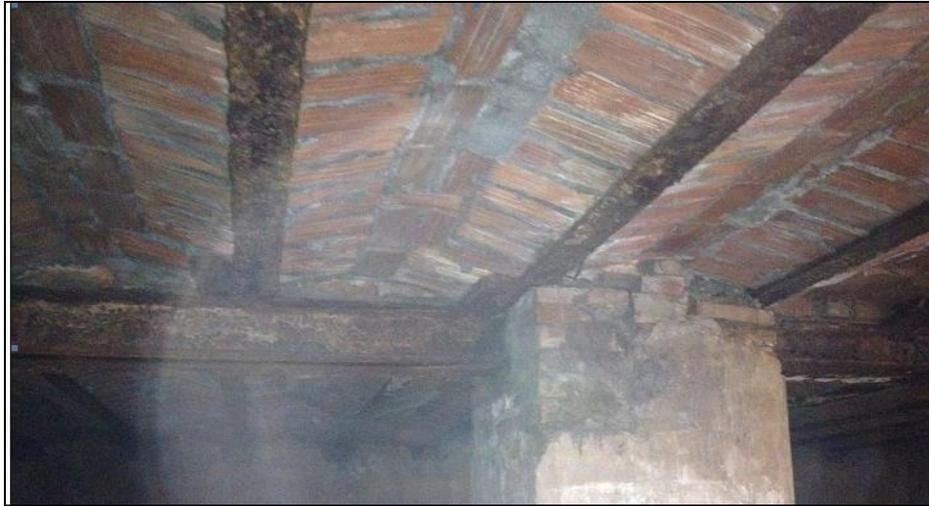
Fig.160, plancher en voutain, sous-sol, source : Pp
