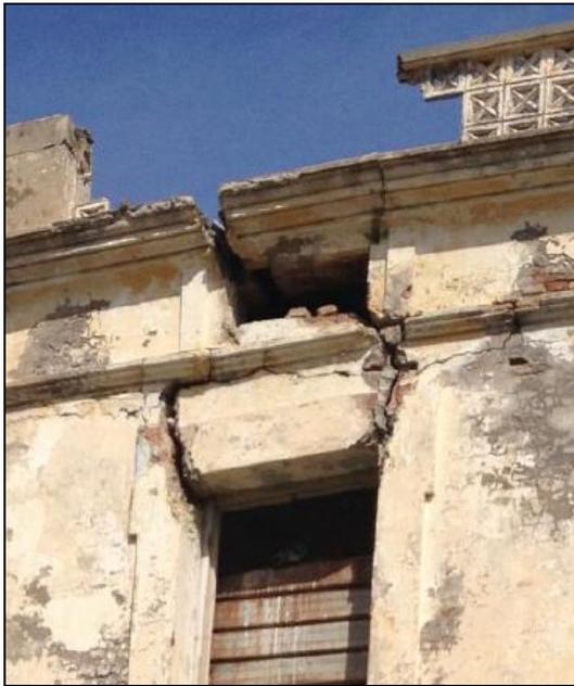
Fig.174, deux fissures verticales entre le linteau
