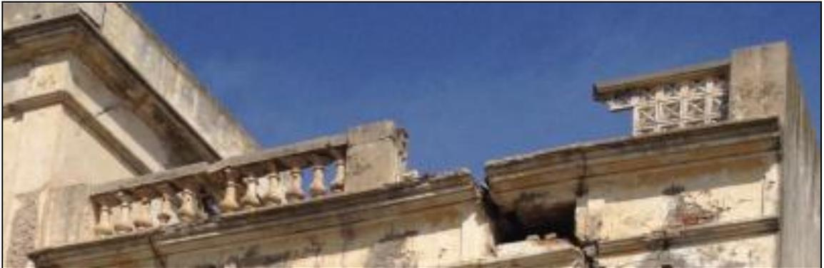
Fig.192, perte de la matière au niveau des carreaux du garde-corps de la
