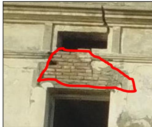
Fig.156, mur intérieur de 50 cm d'épaisseur, source : Pp Fig.157, la brique pleine, mur extérieure, source : Pp
