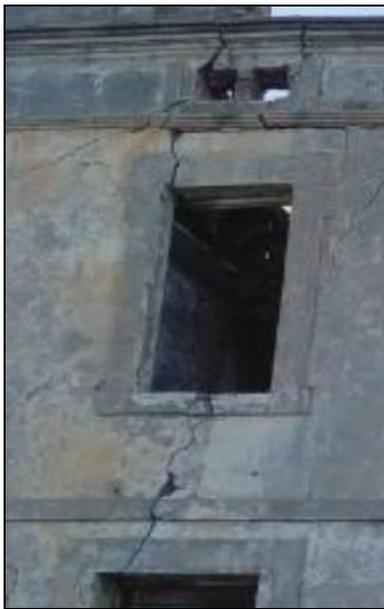
Fig.18, fissure verticale entre les deux fenêtres
