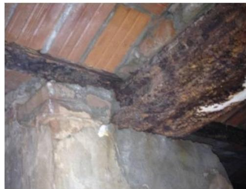
Fig.190, disparition d'une partie de l'enduit des planchers, source : Pp
