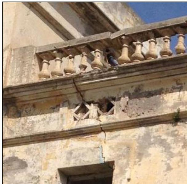
Fig.176, une fissure verticale, du linteau de la fenêtre vers le garde-corps, source : Pp
