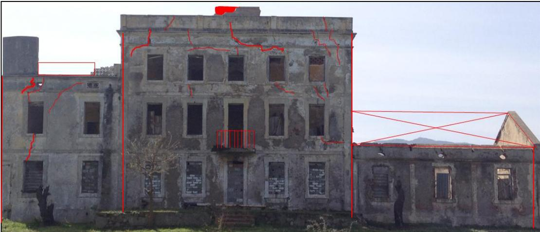
Fig.180, diagnostic des murs 5,6 et7, source : Pp
