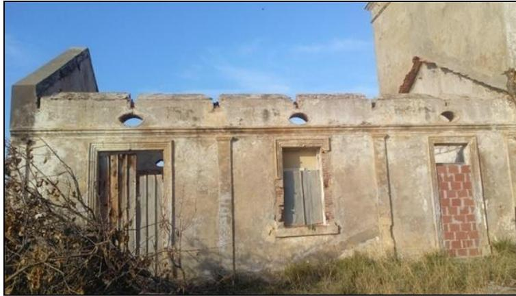
Fig.188, perte de la matière au niveau de la couverture du bloc séparé, source : Pp
