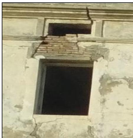
Fig.170, deux fissures verticales au-dessus de la fenêtre et la petite ouverture Et la disparition de l'enduit ciment , source : Pp
