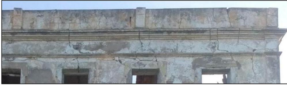
Fig.184, une série de fissures au-dessus des fenêtres et au garde-corps, source : Pp
