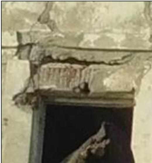
Fig.171, Fissure horizontale au-dessus du Linteau, source : Pp
