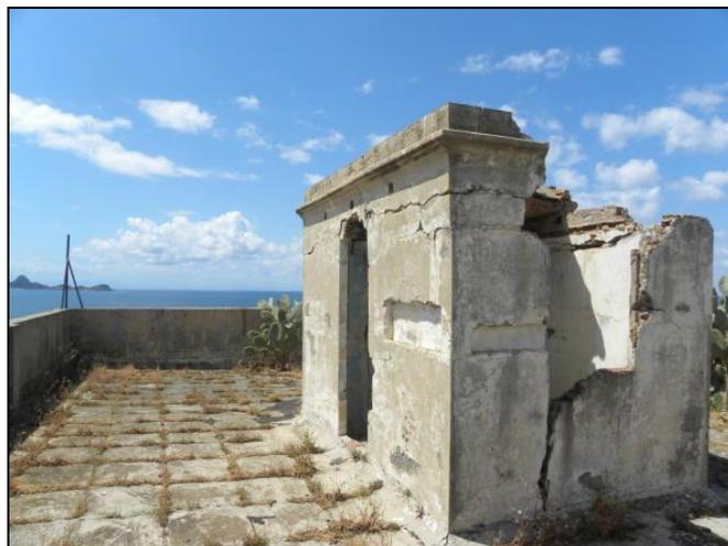
Fig.187, l'effondrement de la toiture et une partie du mur de la buanderie, et une fissure horizontale au niveau de l'autre mur Source : Pp
