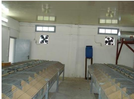
**Figure 04.** Ventilation de la chambre par l'utilisation du système pad-coling
