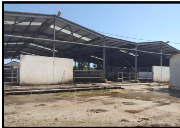
Figure 34 : les 3 lots du premier bâtiment (photo personnel).
