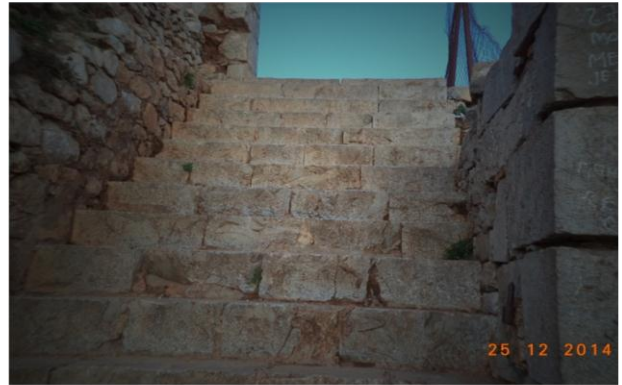
1/ Escalier mener au niveau 676.38
