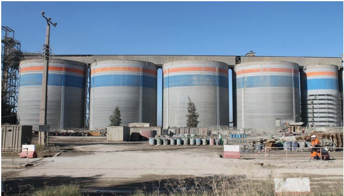
Figure 1.14. Silos de Stockage de Clinker et Gypse.
