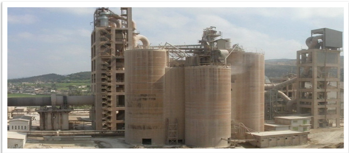
Figure 1.10. Silos d'homogénéisation.
