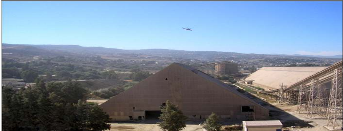
Figure 1.8. Halls de pré homogénéisation.
