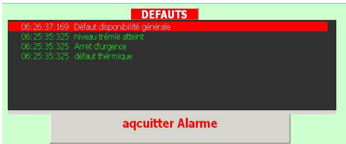
Figure 4.13. Message alarme dans la vue gratteur.
