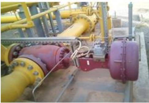
*Figure 2.7.* Vanne régulatrice gaz.
