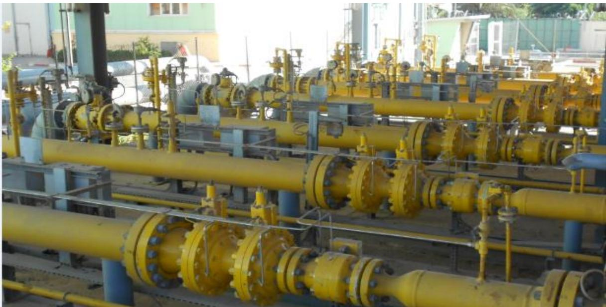
**Figure 2.6.** Poste détente gaz pour les 04 TG.
