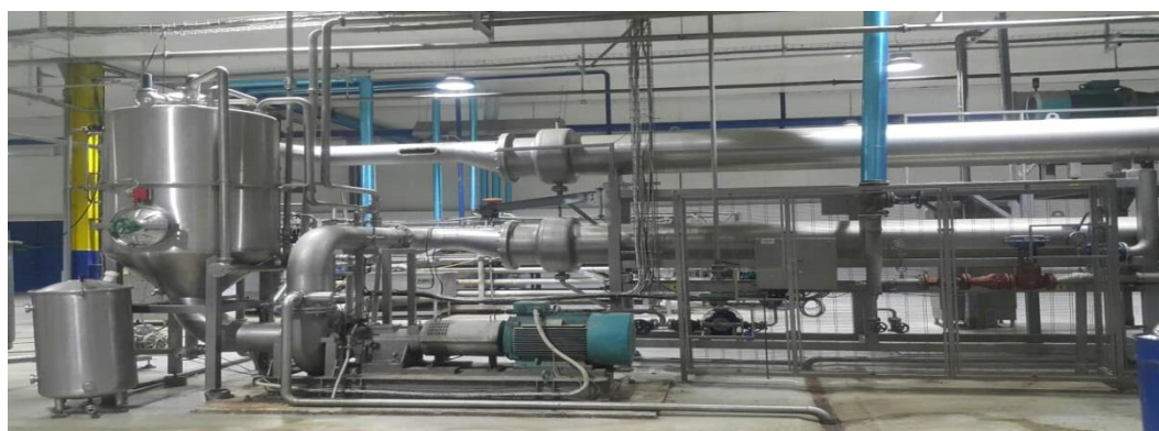
Figure II.2 : Préchauffage du piment (photo originale)
