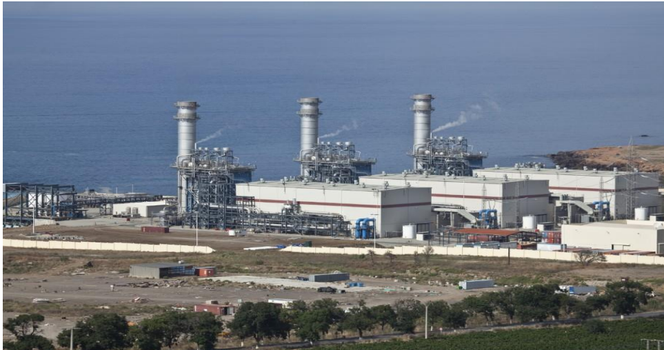
Figure 1-1 : Centrale électrique de SKH [2]
