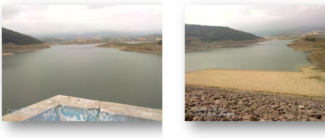
Fig. 13 - Barrage de Boukerdane de Sidi Amar Wilaya de Tipasa (photo, originale)
