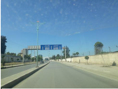
Figure 82: Entrée de ville de Blida, Nouvelle Gare Routière.RN°29. Source : A Auteur
