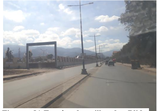
Figure 81: Entrée de ville de Blida, Nouvelle Gare Routière.RN°29 Source : A Auteur
