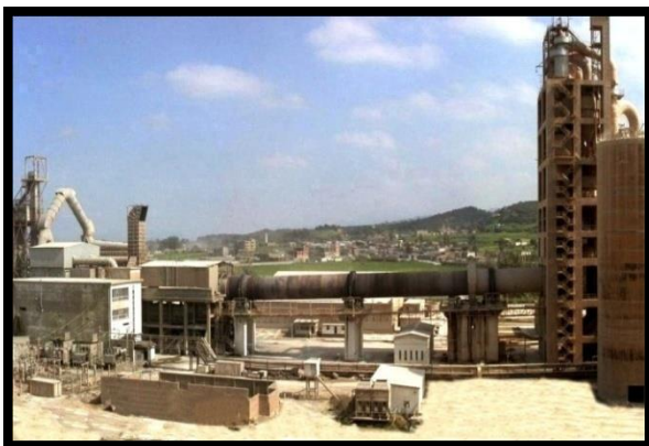
Figure I.8. Ligne de cuisson d'une cimenterie
