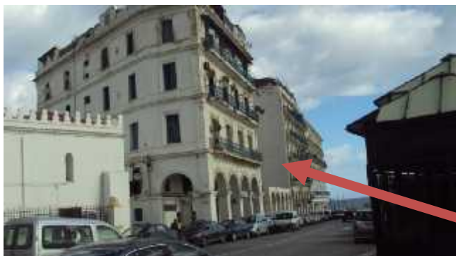
vide dans la façade urbaine
