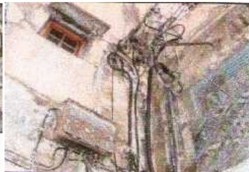
Canalisation détériorée, Avaloirs obstrués, Fuites d'eau potable.
