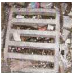
Canalisation détériorée, Avaloirs obstrués, Fuites d'eau potable.
