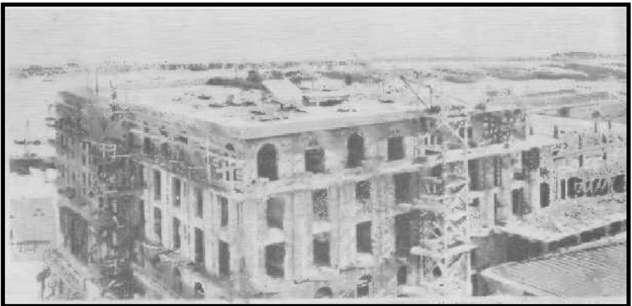
Photo durant la construction décembre 1929 par théo brunad
