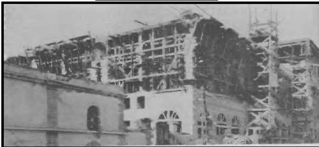
Photo de plancher en plein construction
