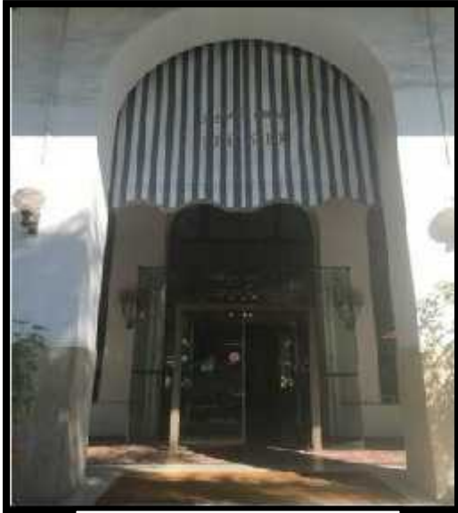
Arc en plein centre
