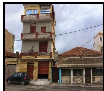
Figure 3.23 : représente des maisons de la façade du front de mer Source : Prise par l'auteur
