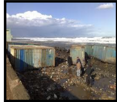
Figure 3.32 : Vue sur la partie Ouest Source : Google image
