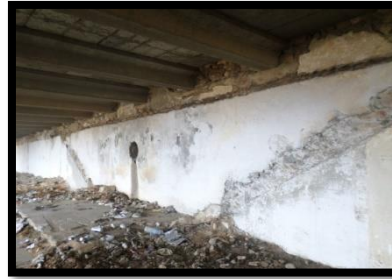
Figure 3.25: montre l'état de la galerie sous les escaliers / Source : Prise par l'auteur
