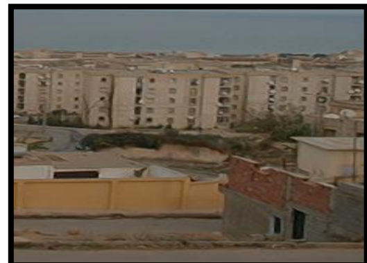
Figure 3.34 : Habitat collectif dans la partie Sud -Est Source : PDAU de Bou Ismail (révision)
