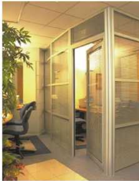
Figure 37 : Cloison vitrée de bureau
