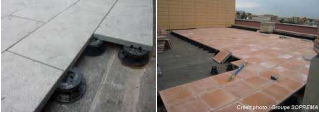
Figure 39 : Démonstration dalles sur plots
