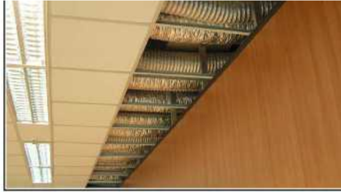
Figure 38 : Démonstration faux plafonds
