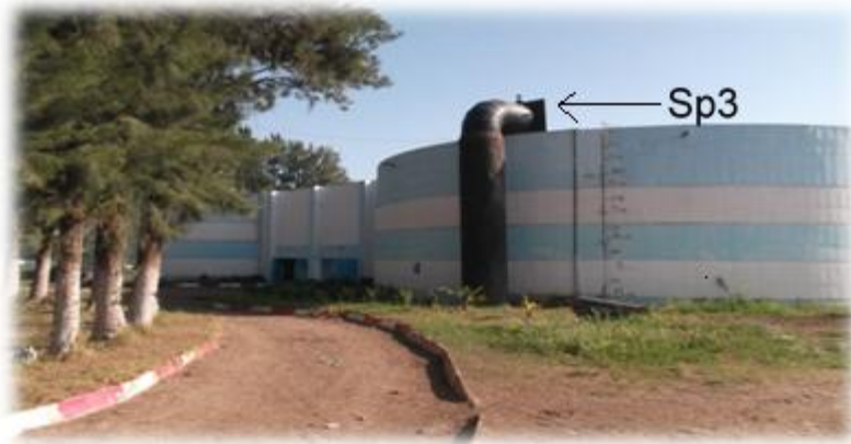
Figure 08: Transfert des eaux de la station de traitement de Magtaa Khira (Sp3) (Photo originale).
