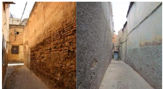
Figure 39 Derb de la médinat de Tlemcen ,source auteurs
