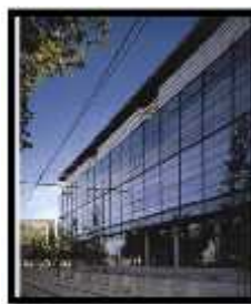
Façade principale Nord
