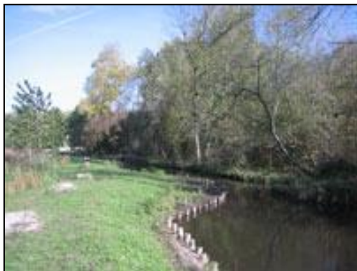
Figure 11 : Mise en place de banquettes d'hélophytes
