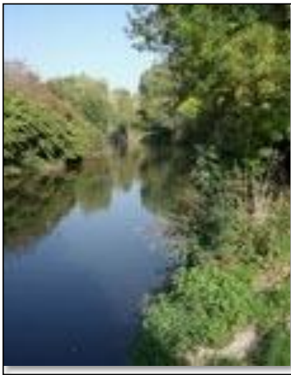
Figure 09 : Situation avant abaissement de l'ouvrage
