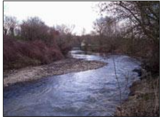
Figure 10 : Situation après abaissement de l'ouvrage
