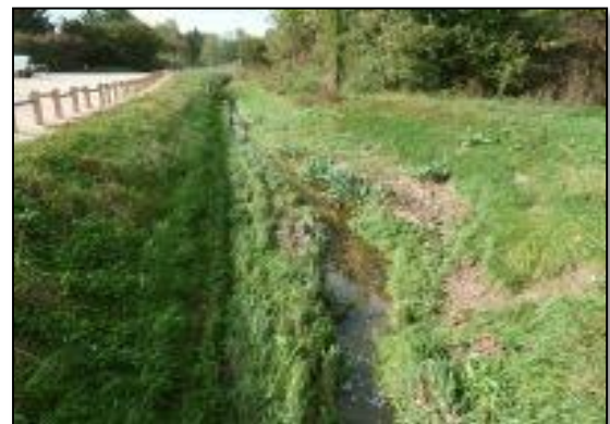
Figure 08: Après travaux de remise à ciel ouvert
