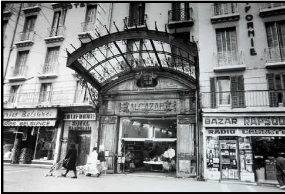
Figure2. L'ancienne façade (avant l'intervention)
