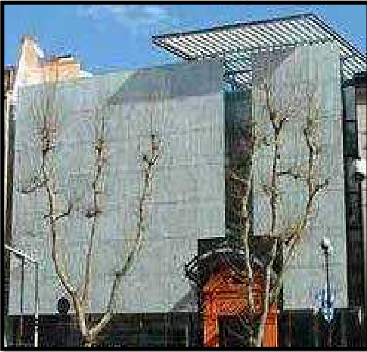
Figure14.La Façade après l'intervention
