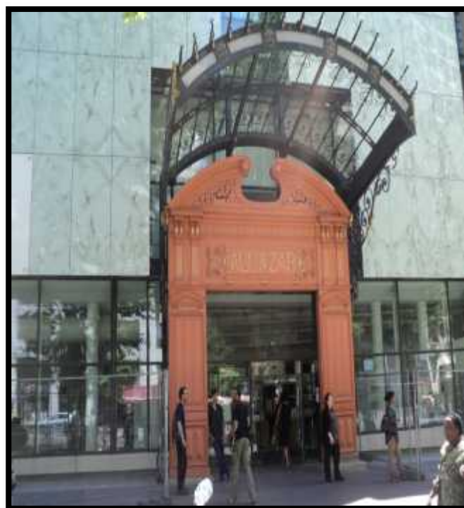
Figure 7. L'entrée Après l'intervention
