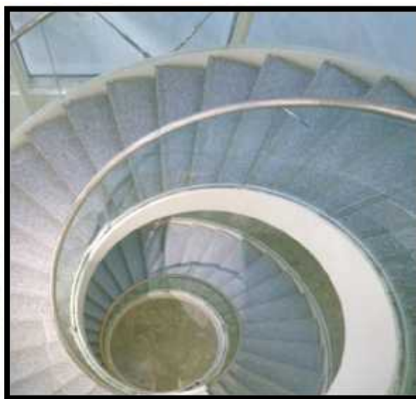
Figure 13. Escalier Salle de conférence
