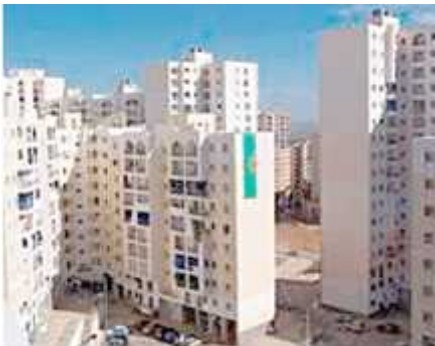
Photo 04 : Les espaces des batiments
