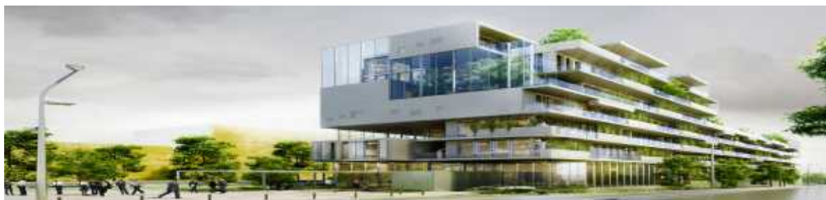
Figure III -20 : Immeuble CNFPT Lille, France.
