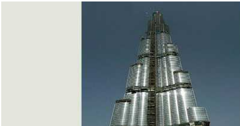
Figure II-16 :la pose des vitres du Burj Khalifa. Source: Jean-Paul Cipria - août• 28•12
