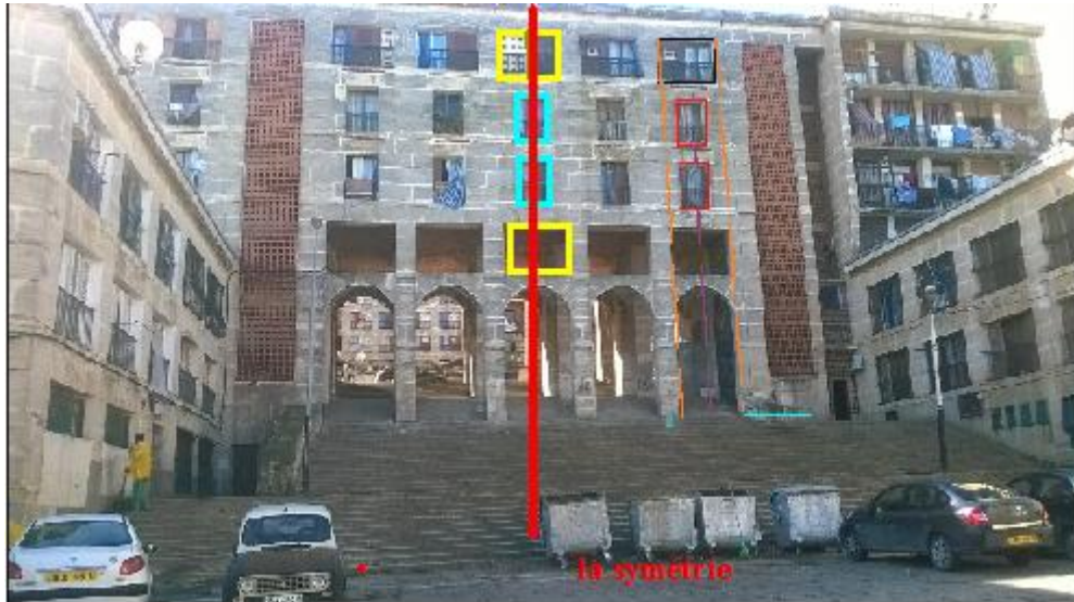
Fig. 15 : Façade principale "Diar El Mahcoul" Fernand Pouillon ,1954
