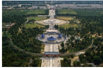
Fig. 20 Le Temple du Ciel entouré d'une enceinte est en Chine le plus grand ensemble d'architecture pour les rites
