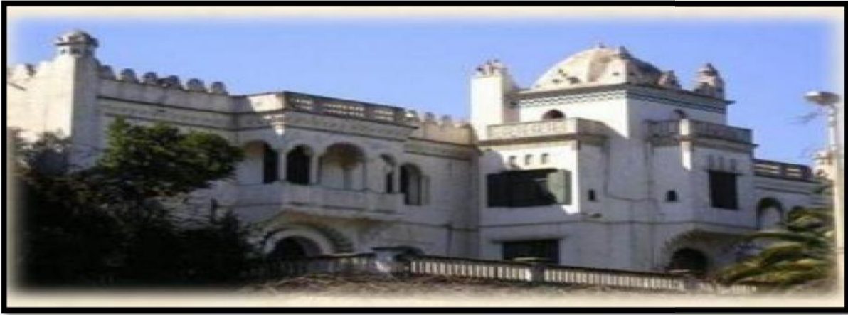
Fig.5 : image de l'extérieur de la maison.
