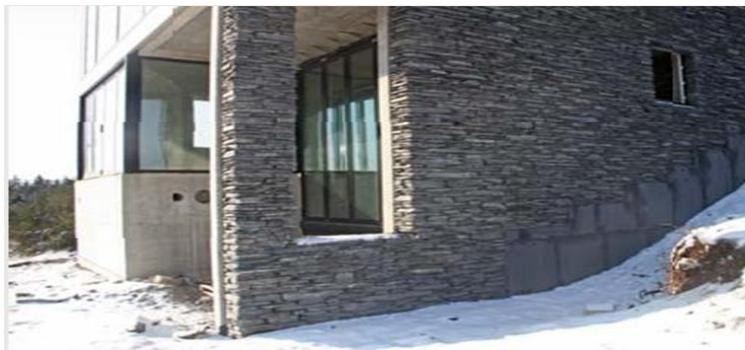
Le parement en maçonnerie recherche un aspect massif, proche de l'apparence d'un mur à sec. Des photos ont guidé les maçons dans leur travail. La maçonnerie n'est pas rejointoyée mais le schiste est posé sur une très faible épaisseur de mortier, le minimum nécessaire.
