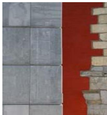
Côté pierre, c'est le traitement des baies, en général encadrées de pierre bleue, qui est le principal sujet de travail. Les nouvelles ouvertures, limitées, sont traitées sobrement par un simple percement étroit dans la brique, ce qui en minimise l'impact et les différencie clairement des anciennes dans un souci de cohérence patrimoniale.
