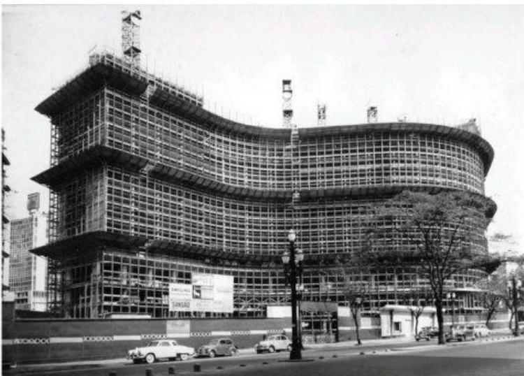
Construction en béton armé
