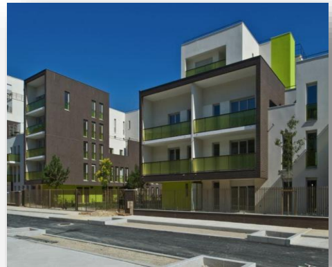
Fig13.54 Logements à saint -Denis
