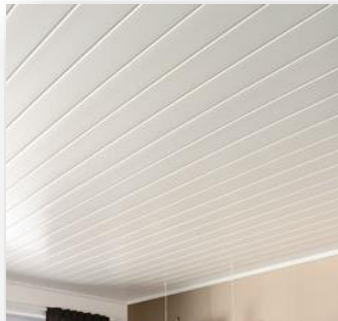
Fig71. Faux plafond en plaques de plâtres
