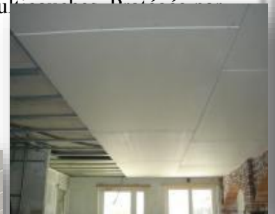
Fig72. Faux plafond en PVC
