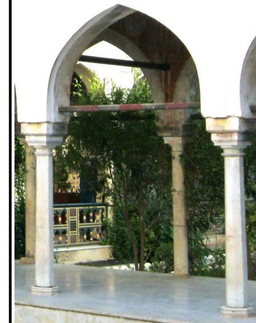
Photo représentant une arcature. source: les auteurs.
