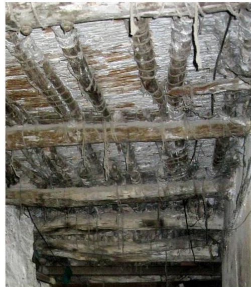
Photo représentant le principe du plancher traditionnel source: les auteurs
