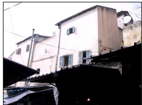
Photo 23 : Vue sur la façade mixte de la maison à patio. Source : BET Oudaddi.
