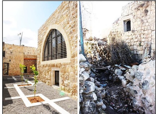
Photo 9 : vue sur le projet avant et après Source : revue de Michele Lamprakos Architect et historienne (Agha Khan Award of Architecture)
