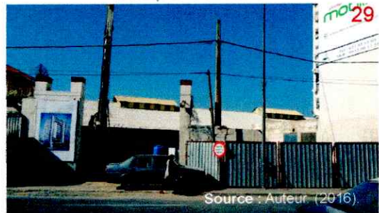
Figure 60 : Photo d'un Chantier.
