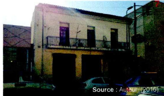
Figure 38 : Photo d'une maison R+1.
