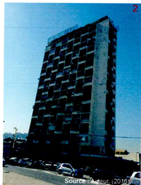
Figure 33 : Photo de l'immeuble Pernot.
