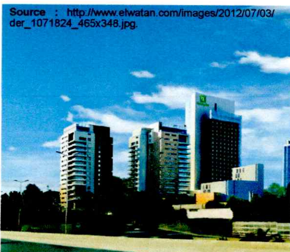
Figure 110 : Vue sur les deux tours d'habitat et l'hôtel.
