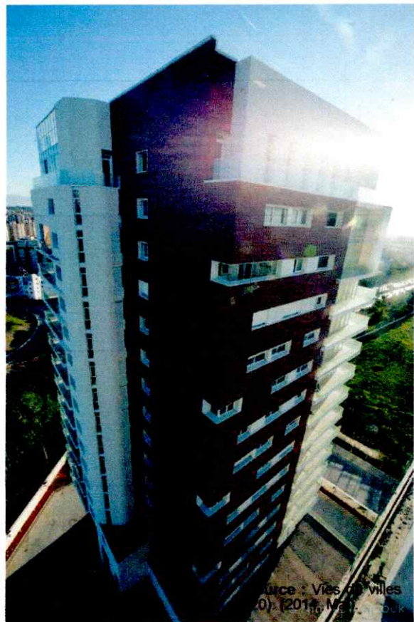
Figure 112 : Vue aérienne d'une tour.
