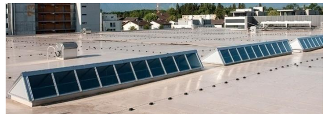
Figure 26: exemple des sheds-lanterneaux. (source : http://www.energieplus-lesite.be )
