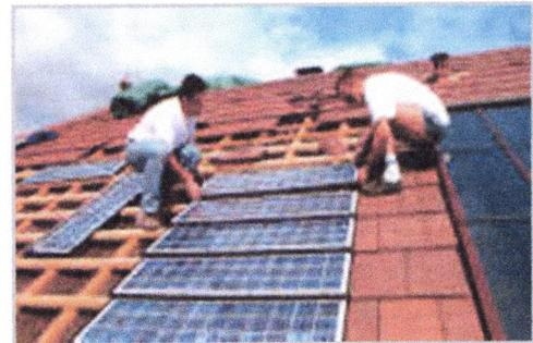
Fig.2.36 : ex d'une Tuile solaire
