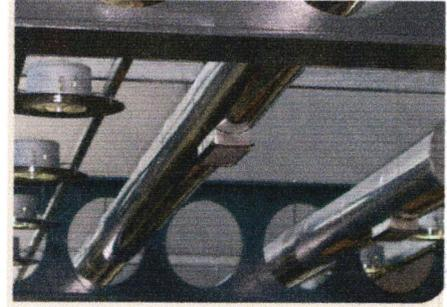
Fig.1.31: exemple d'une poutre alvéolaire
