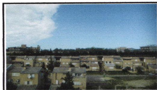
Fig26 : Vue sur les facades
