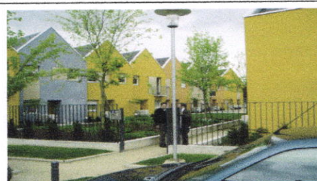
Fig13 : Résidence Anne Frank ; vert-saint – dennis (77) 19 logement (individuelle groupé)
