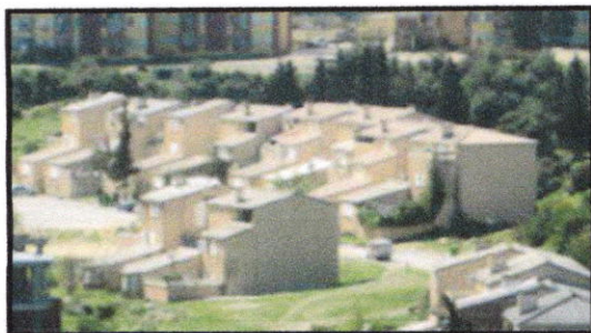
Fig25 : Vue sur les facades
