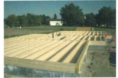
**Figure 18 :** Pose sur des semelles isolées.
