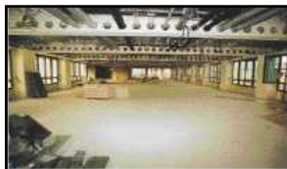
Figure04.25 : : Passage des gaines par les alvéoles métallique
