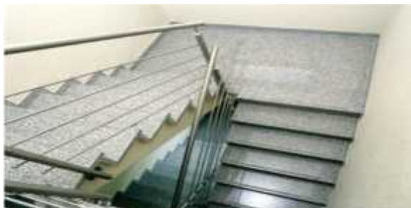
Figure04.22: cage d'escalier en béton armé
