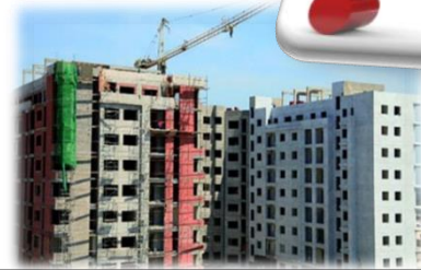
Fig10 : bâtiments en cour de réalisation en Algérie
