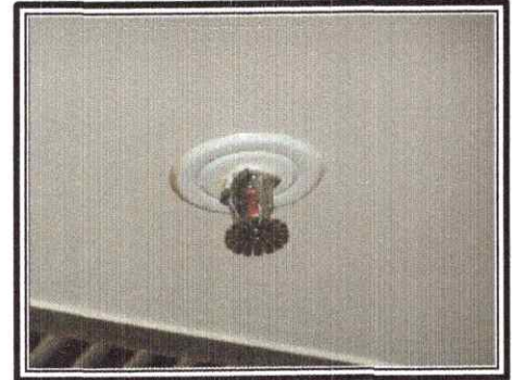
Figure 3. 45 : Système d'incendie Source : Mémoire de Master
