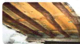
Poutre en bois de la maison de la casbah d'Alger - source web -
