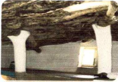
la structure en bois de la maison - source web -
