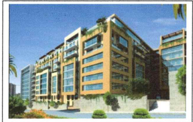
Vue sur la façade principale
